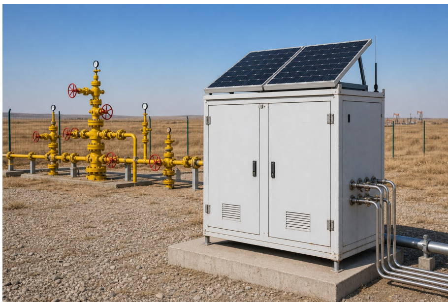
气田现场应用 · 智能加注装置与采气树协同运行（效果图）
